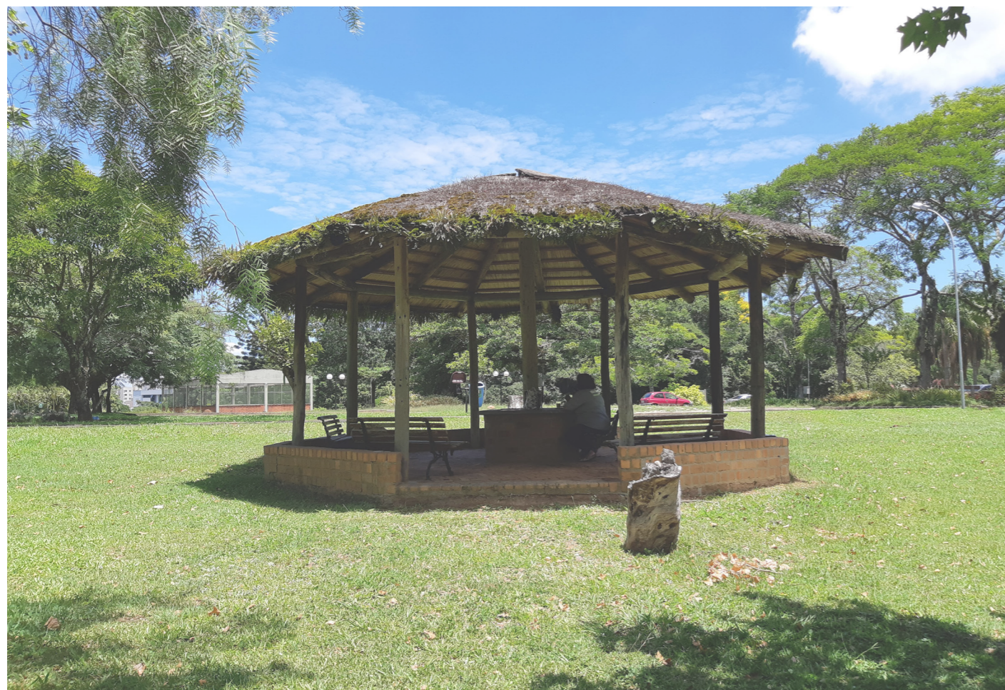
Figura 59. Foto da edificação. Fonte: visita técnica feita pela equipe em fevereiro de 2021
