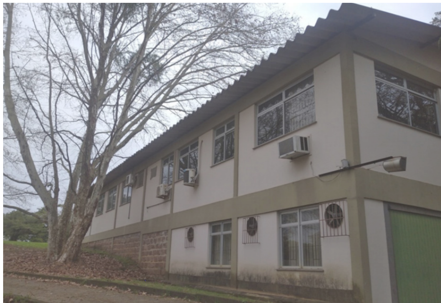
Figura 49. Foto da edificação. Fonte: visita técnica feita pela equipe em fevereiro de 2021
