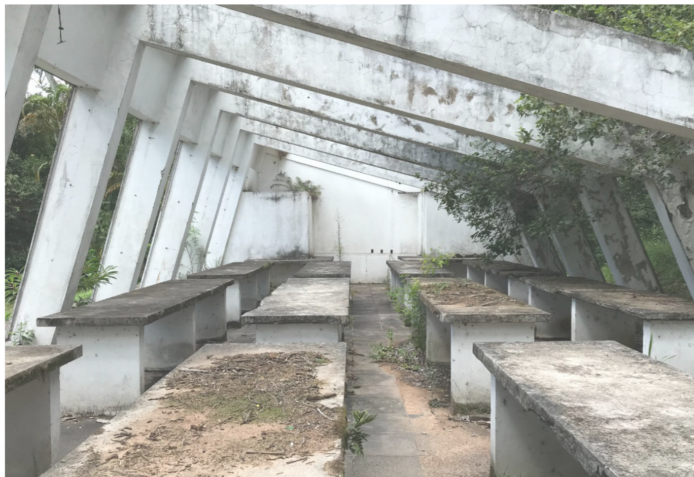
Figura 11. Foto da edificação. Fonte: visita técnica feita pela equipe em fevereiro de 2021
