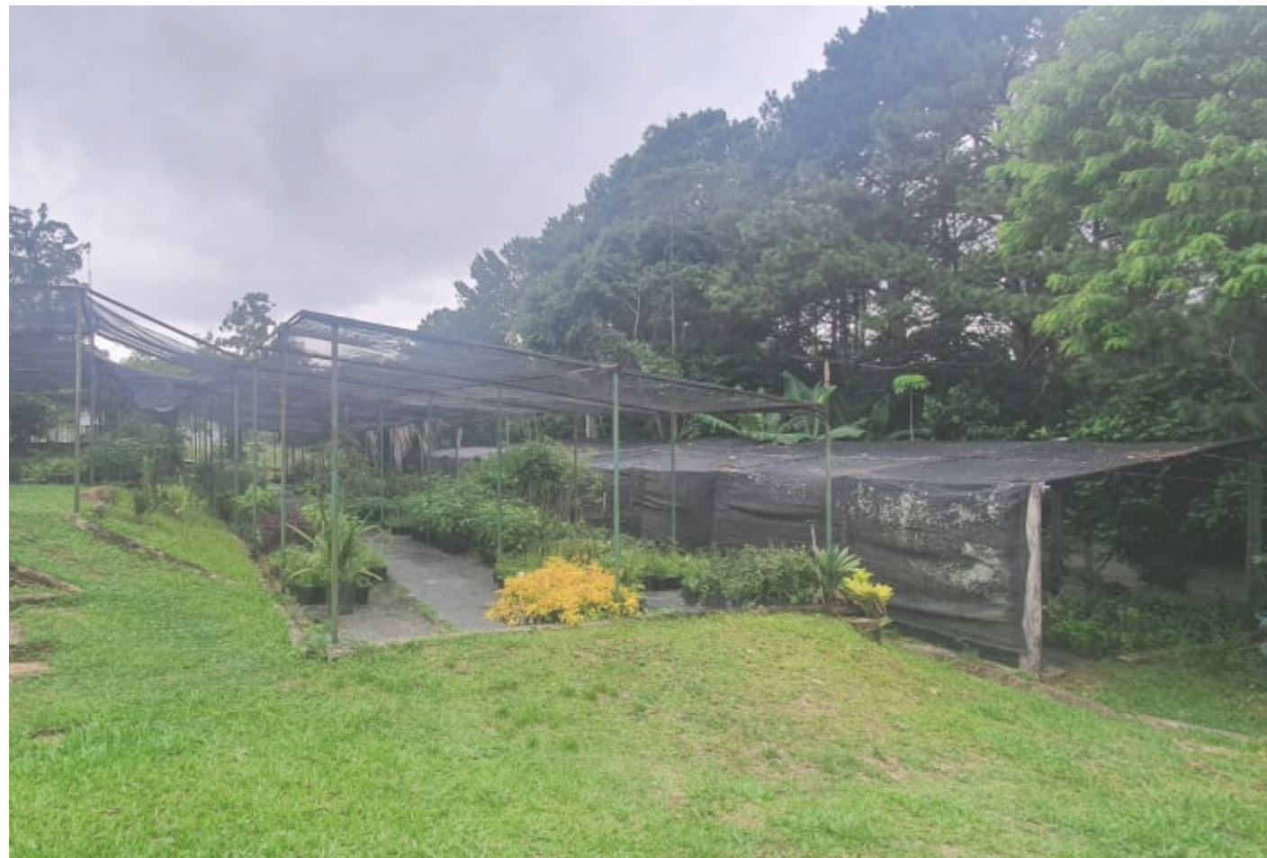
Figura 45. Foto da edificação. Fonte: visita técnica feita pela equipe em fevereiro de 2021
