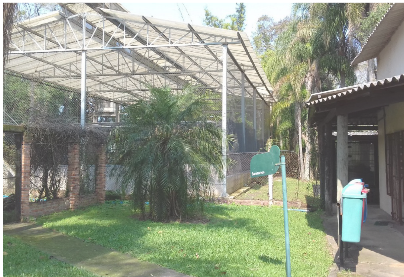
Figura 37. Foto da edificação. Fonte: visita técnica feita pela equipe em fevereiro de 2021
