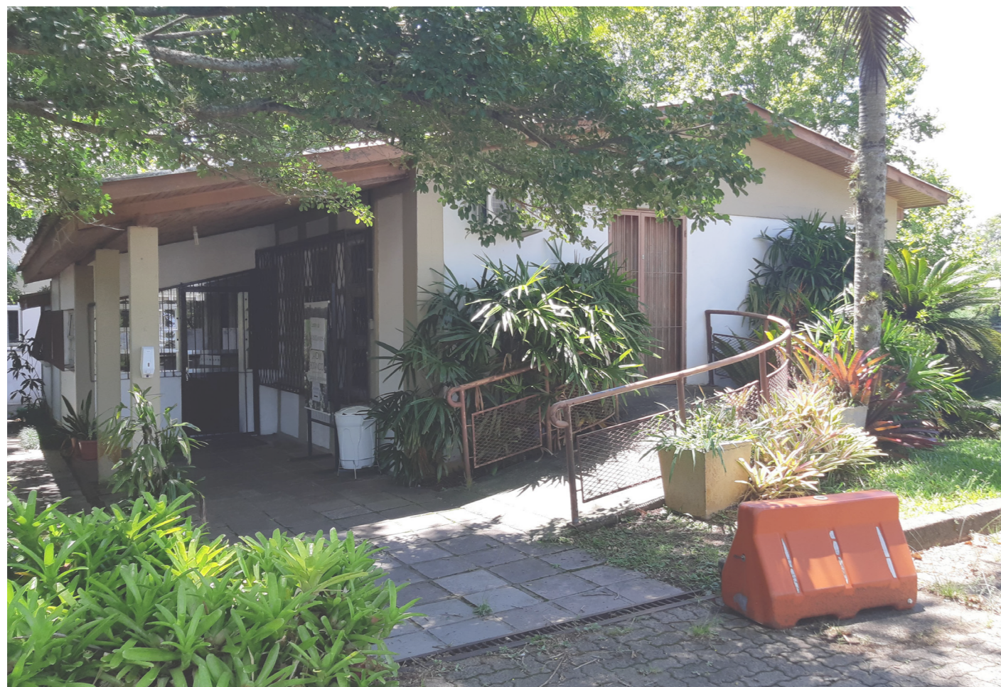
Figura 17. Foto da edificação. Fonte: visita técnica feita pela equipe em fevereiro de 2021
