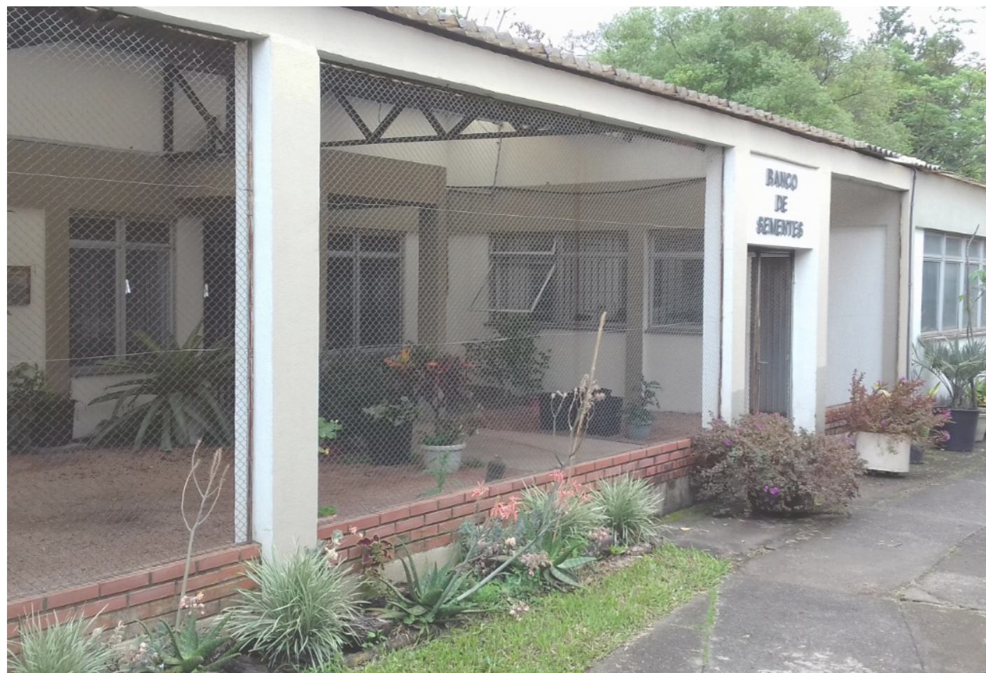
Figura 39. Foto da edificação. Fonte: visita técnica feita pela equipe em fevereiro de 2021
