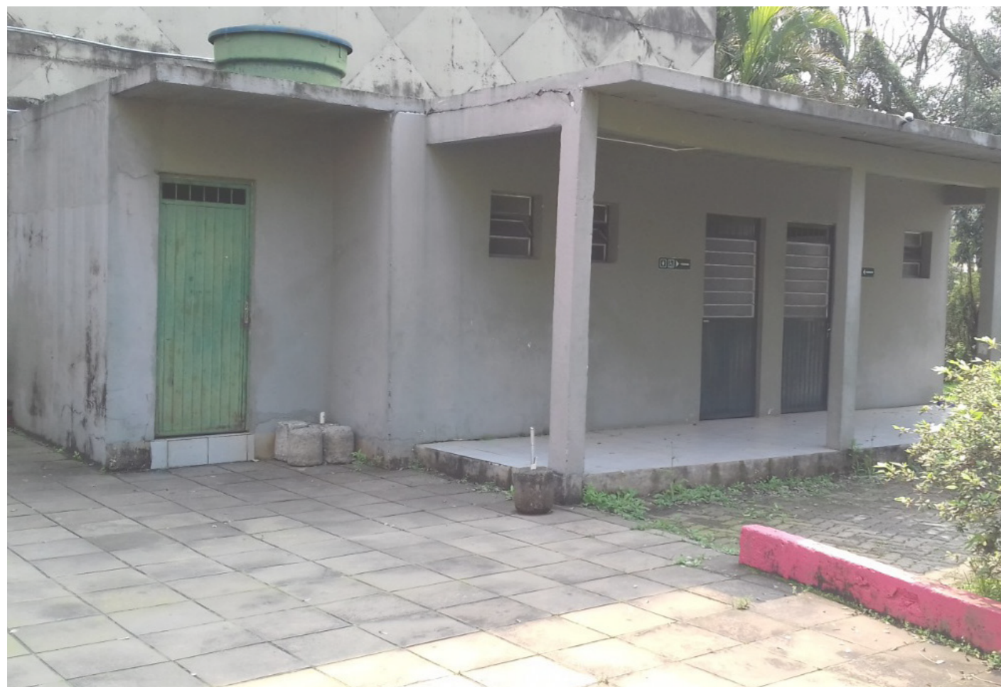
Figura 53. Foto da edificação. Fonte: visita técnica feita pela equipe em fevereiro de 2021
