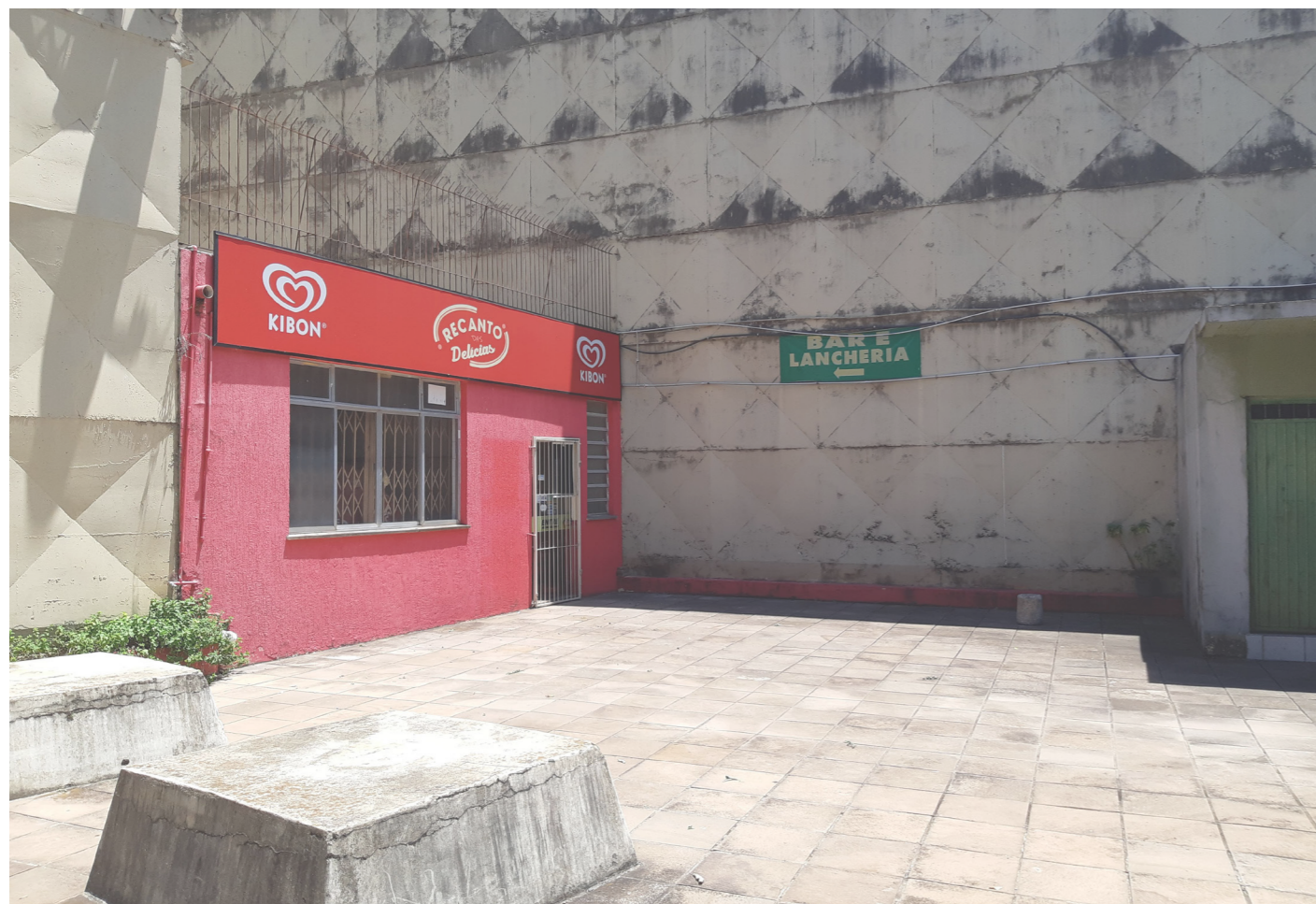
Figura 55. Foto da edificação. Fonte: visita técnica feita pela equipe em fevereiro de 2021
