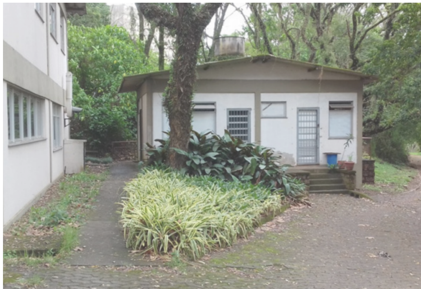
Figura 51. Foto da edificação. Fonte: visita técnica feita pela equipe em fevereiro de 2021
