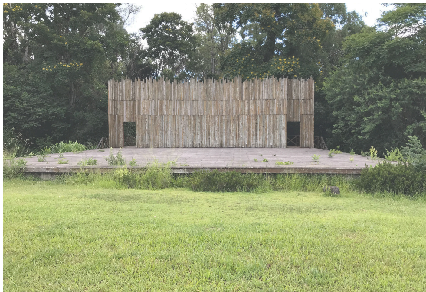
Figura 25. Foto da edificação. Fonte: visita técnica feita pela equipe em fevereiro de 2021
