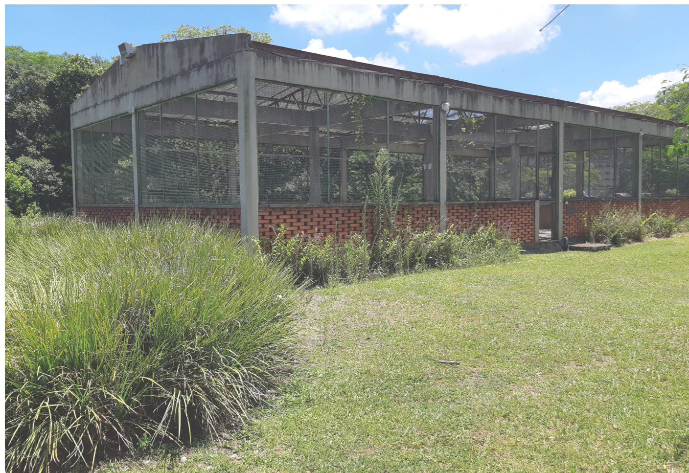
Figura 23. Foto da edificação. Fonte: visita técnica feita pela equipe em fevereiro de 2021
