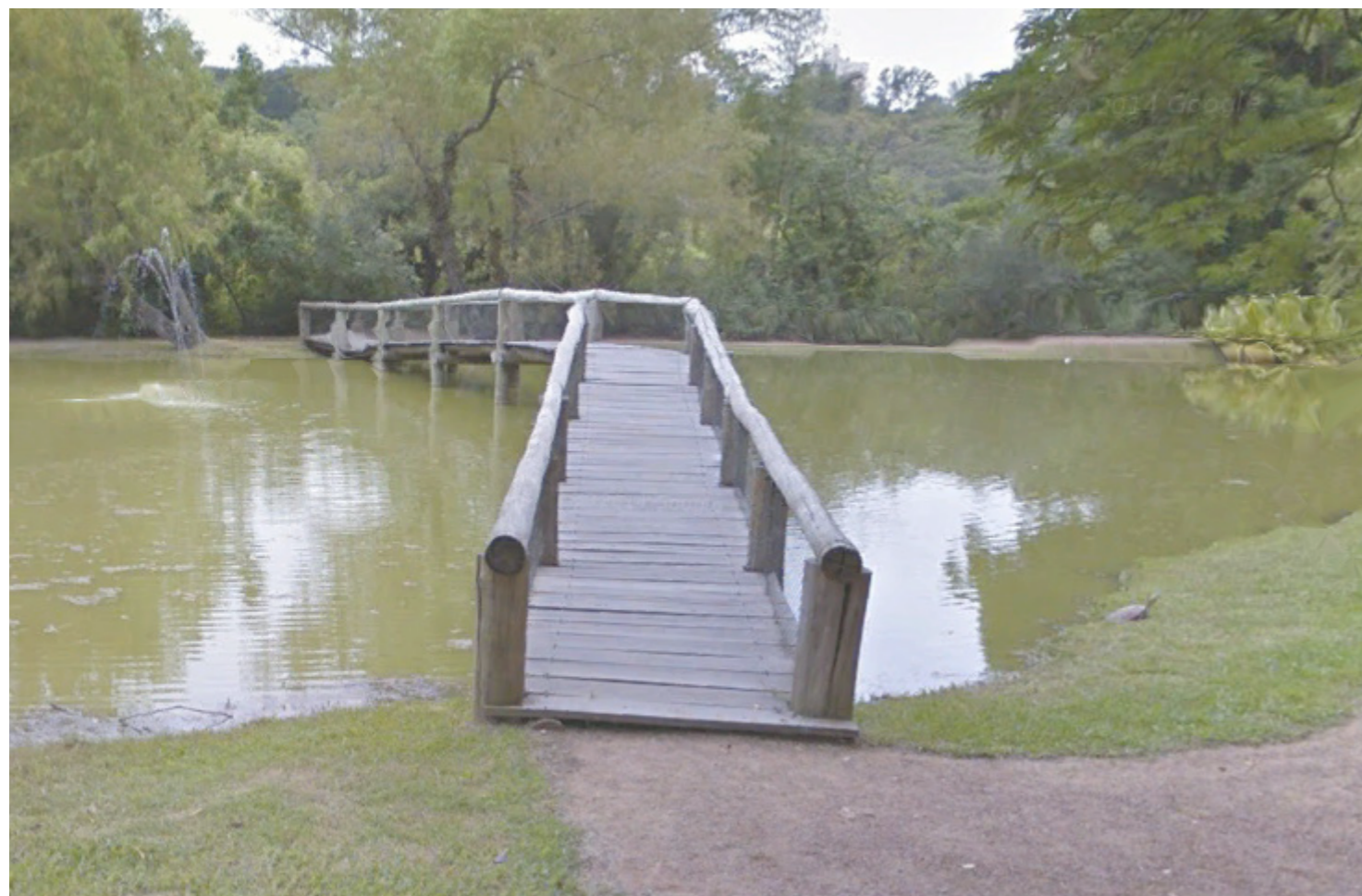
Figura 9. Foto da edificação. Fonte: visita técnica feita pela equipe em fevereiro de 2021
