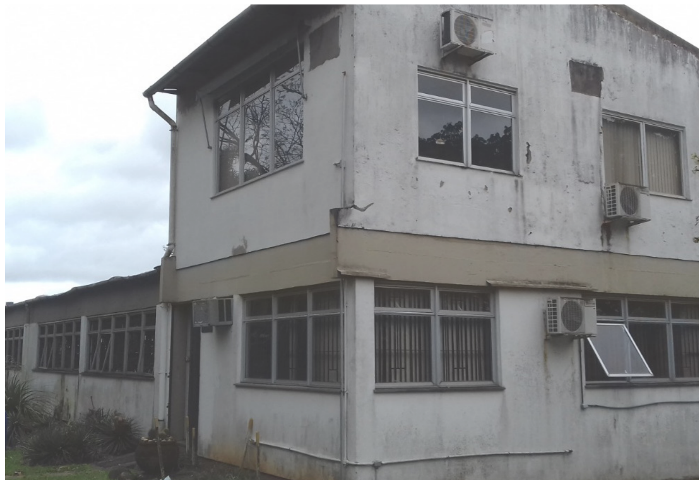
Figura 31. Foto da edificação. Fonte: visita técnica feita pela equipe em fevereiro de 2021
