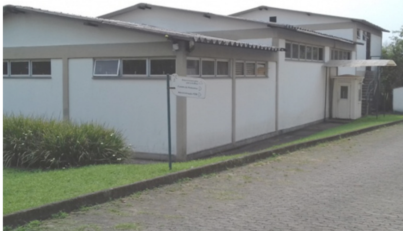
Figura 47. Foto da edificação. Fonte: visita técnica feita pela equipe em fevereiro de 2021
