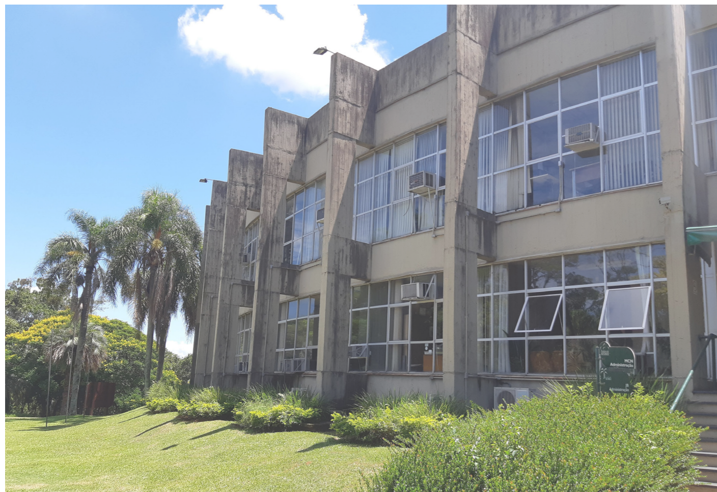
Figura 15. Foto da edificação. Fonte: visita técnica feita pela equipe em fevereiro de 2021
