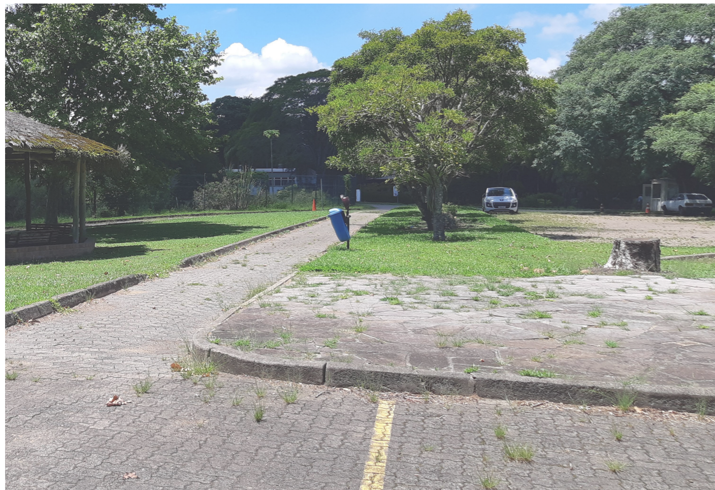
Figura 19. Foto da edificação. Fonte: visita técnica feita pela equipe em fevereiro de 2021
