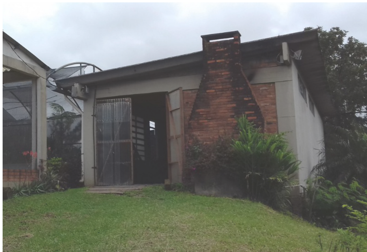
Figura 35. Foto da edificação. Fonte: visita técnica feita pela equipe em fevereiro de 2021
