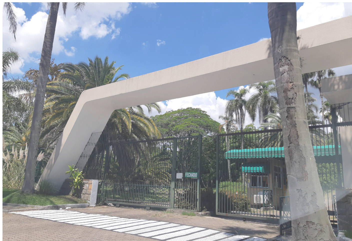
Figura 7. Foto da edificação. Fonte: visita técnica feita pela equipe em fevereiro de 2021
