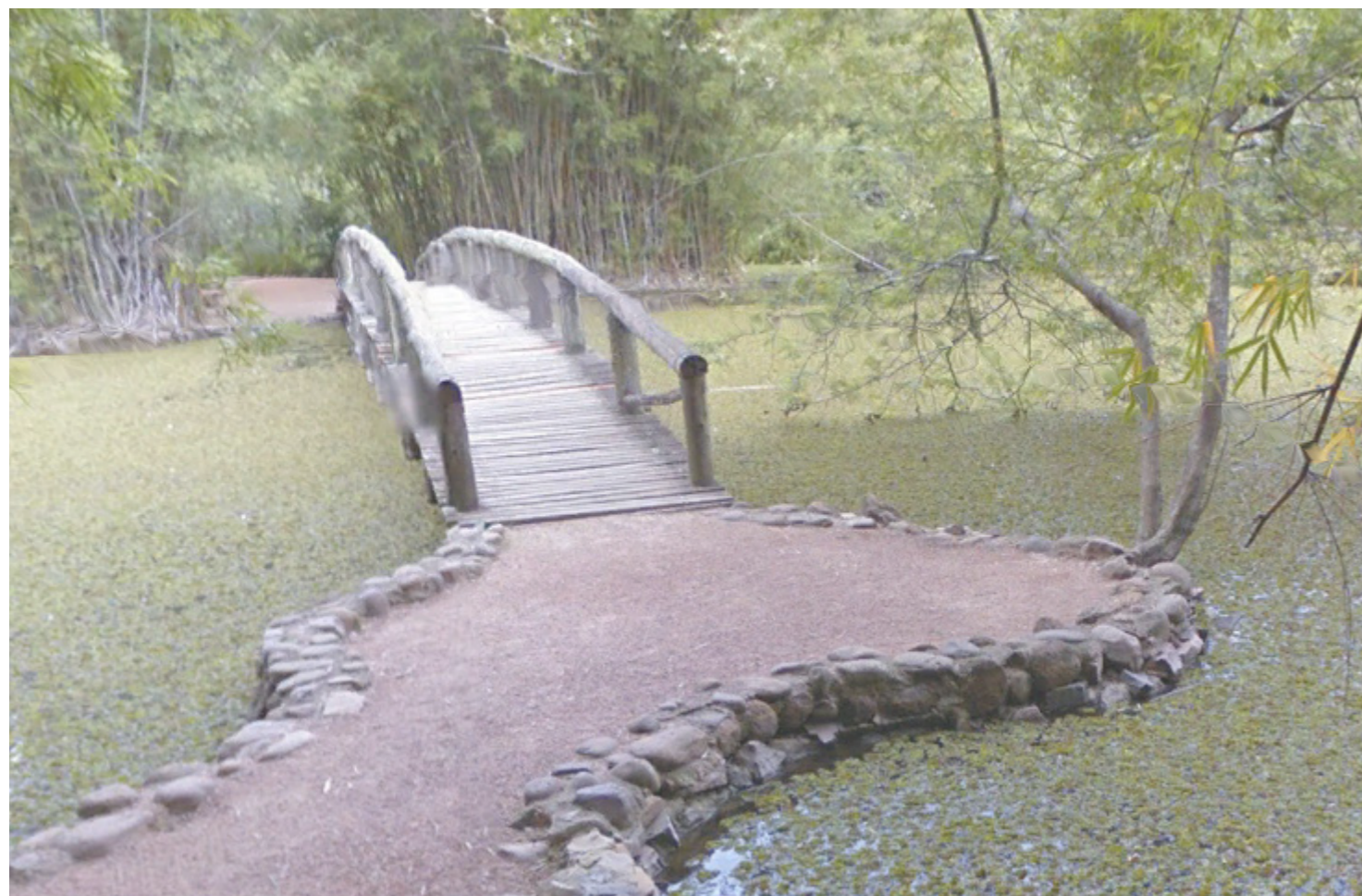
Figura 21. Foto da edificação. Fonte: visita técnica feita pela equipe em fevereiro de 2021
