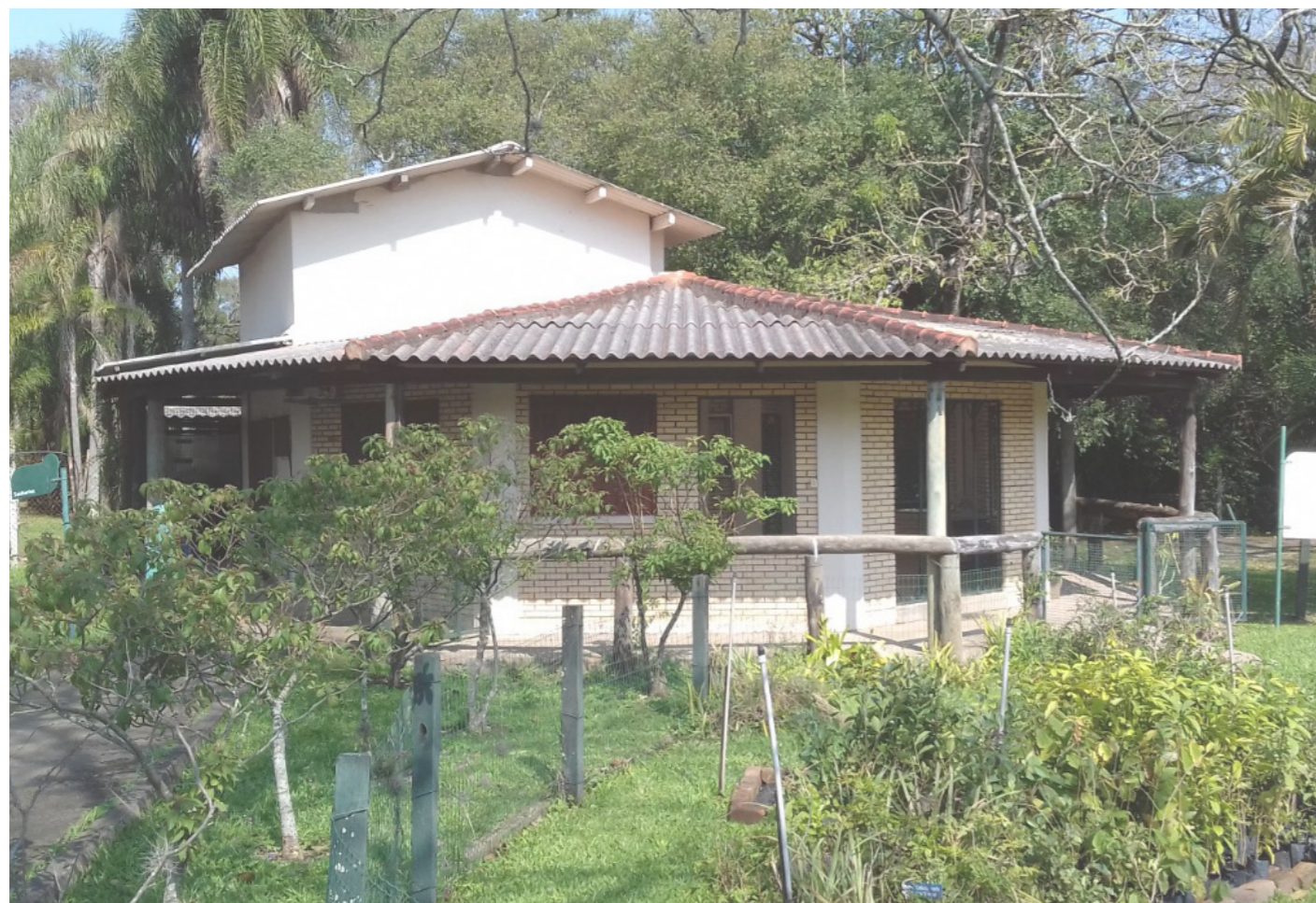
Figura 29. Foto da edificação. Fonte: visita técnica feita pela equipe em fevereiro de 2021
