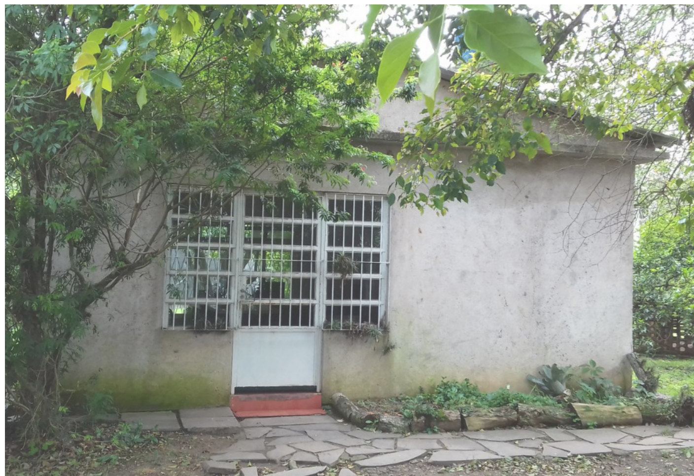
Figura 41. Foto da edificação. Fonte: visita técnica feita pela equipe em fevereiro de 2021
