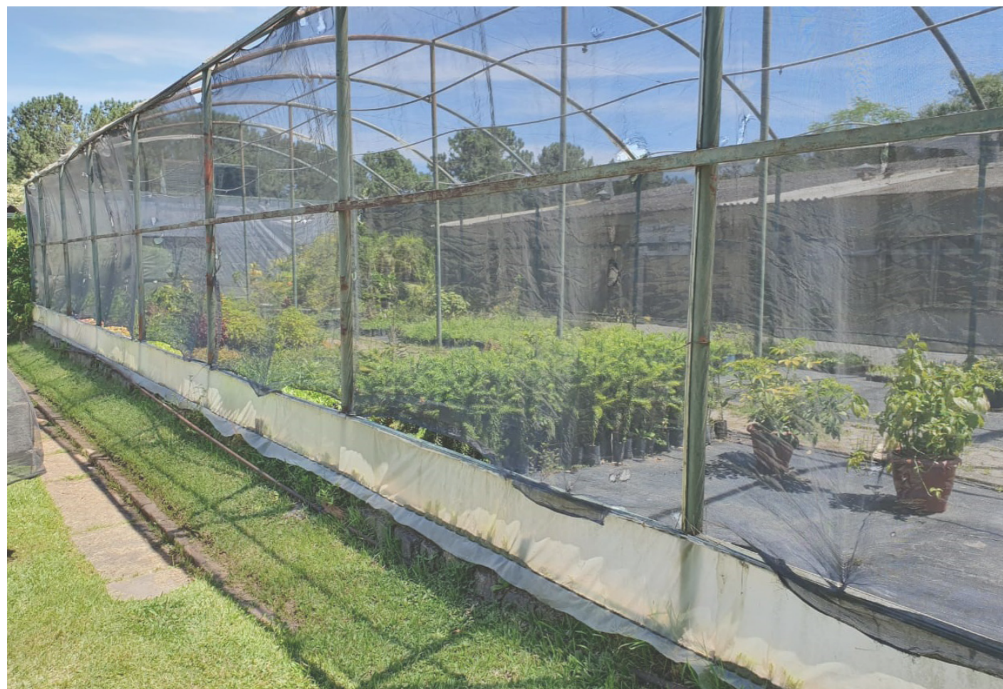
Figura 33. Foto da edificação. Fonte: visita técnica feita pela equipe em fevereiro de 2021
