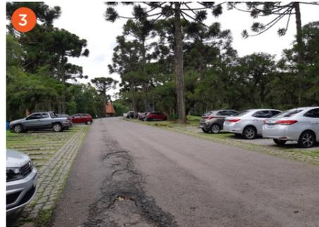
**Bolsão de Estacionamento:** A pavimentação da via central de distribuição das vagas deverá receber reparos ou nova pavimentação, as vagas tem um tratamento de pavimentação com caráter rustico e permeável que pode ser mantido, porém deverá receber uma melhor drenagem, distribuição das vagas com demarcação e sinalização adequadas.
